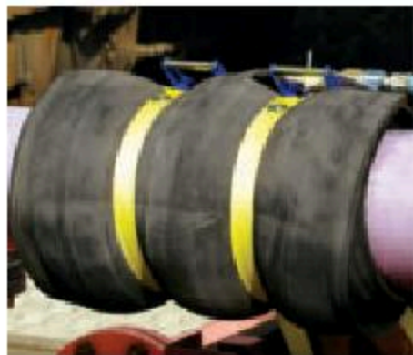
Рис. 26. Резиновый бинд на стыках труб
